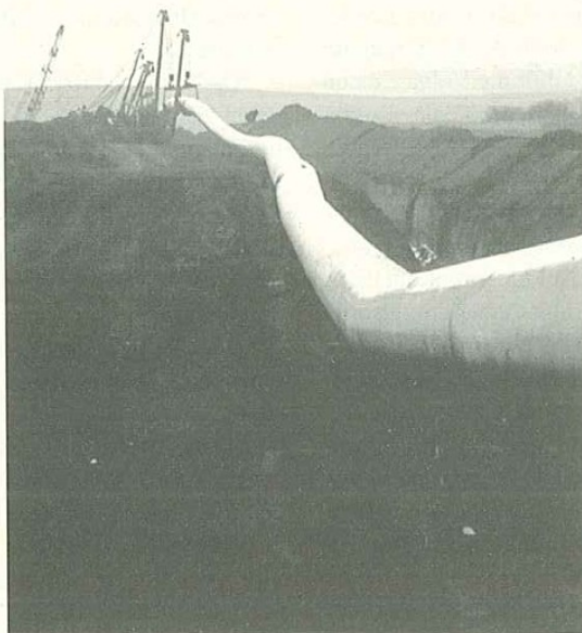
Posa di un oleodotto.
