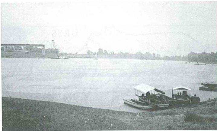
Il ponte spezzato sul fiume al confine fra Croazia e Bosnia (Foto di Fernanda Fevi)
